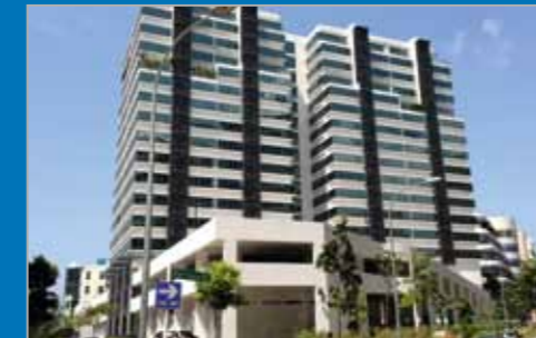
Singapur Vertriebs- und Servicestandort Thermomanagement Bus
